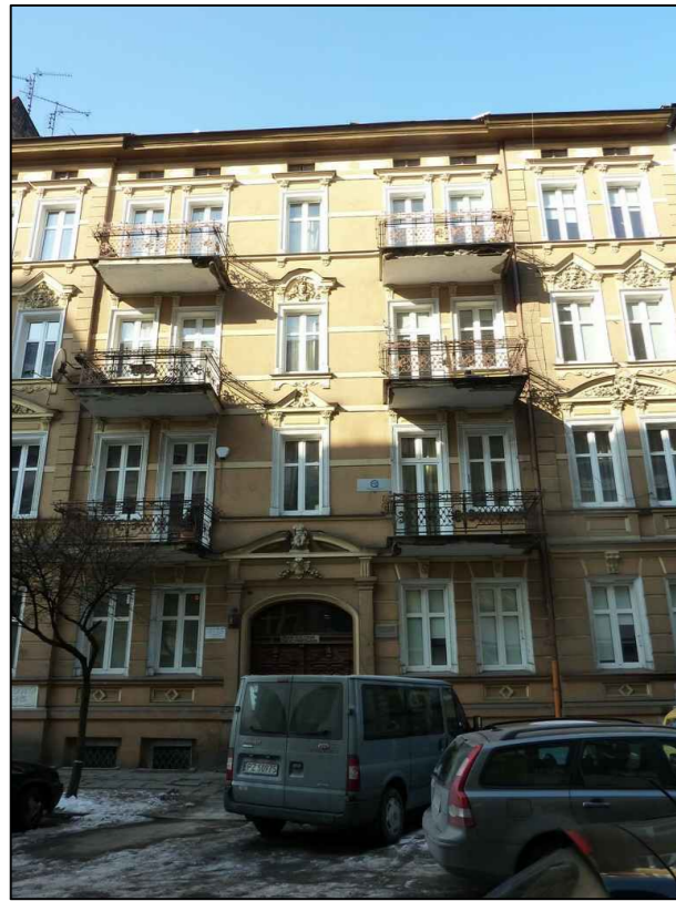
ELEWACJA FRONTOWA BUDYNKU-CZĘŚĆ
