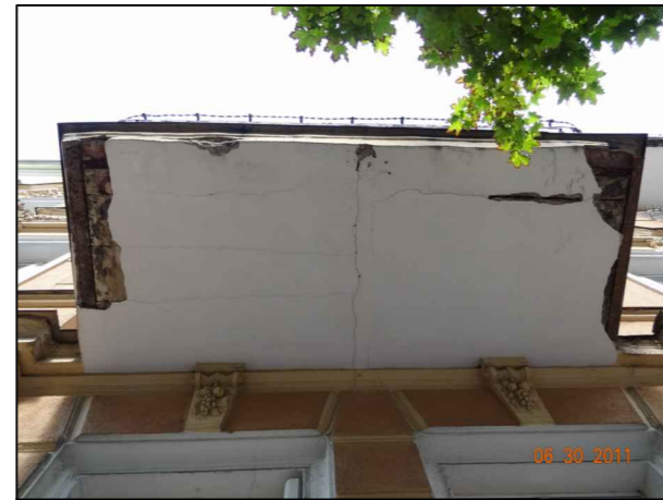
WIDOK BALKONU-OD SPODU
